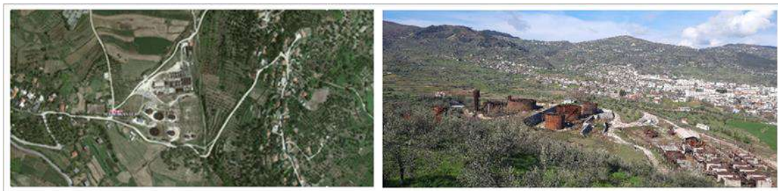
Fig. 127: Pamje e Impiantit të Dekantimit Usojë
