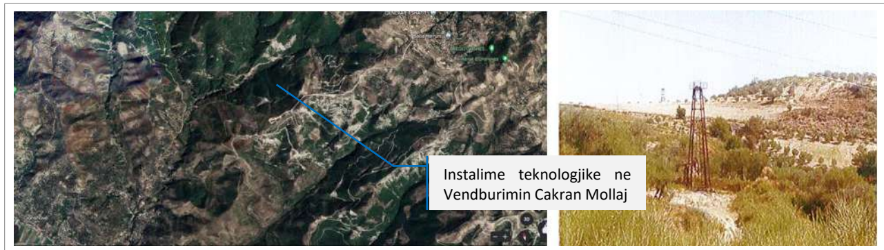
Fig. 121: Instalimet e impianteve të naftës brut në vendburimin Cakran-Mollaj (kompania “Albpetrol” sh.a.).
