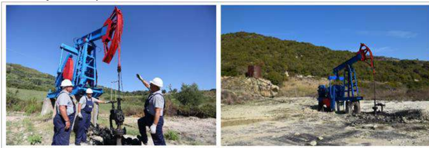
Fig. 122: Instalimet e impianteve të naftës brut në vendburimin Ballsh-Hekal
