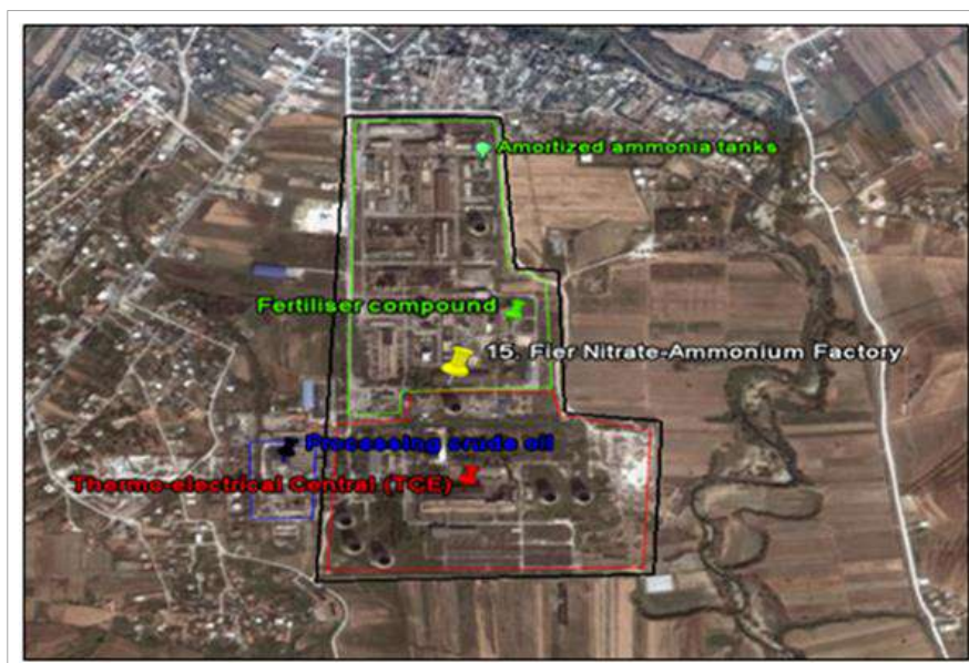
Fig. 172: Gjendja e Objekteve teknologjike në ish Zonën Industriale Fier (Viti 2008)
