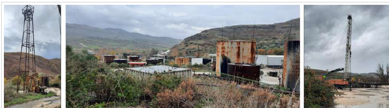
Fig. 120: Instalimet e impianteve të naftës brut në vendburimin Visokë (kompania "Terra Oil Swiss")
